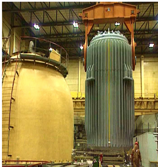
АЭС Грейфсвальд. Демонтаж реактора
